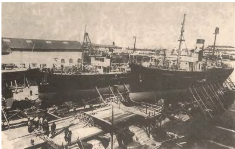
Da destra a sinistra: Guerrazzi, Elba e Cappellini pronti, nel Cantiere Orlando di Livorno, al varo (foto aprile 1912) ancora con l'insegna dell'Allodi sui fumaioli
