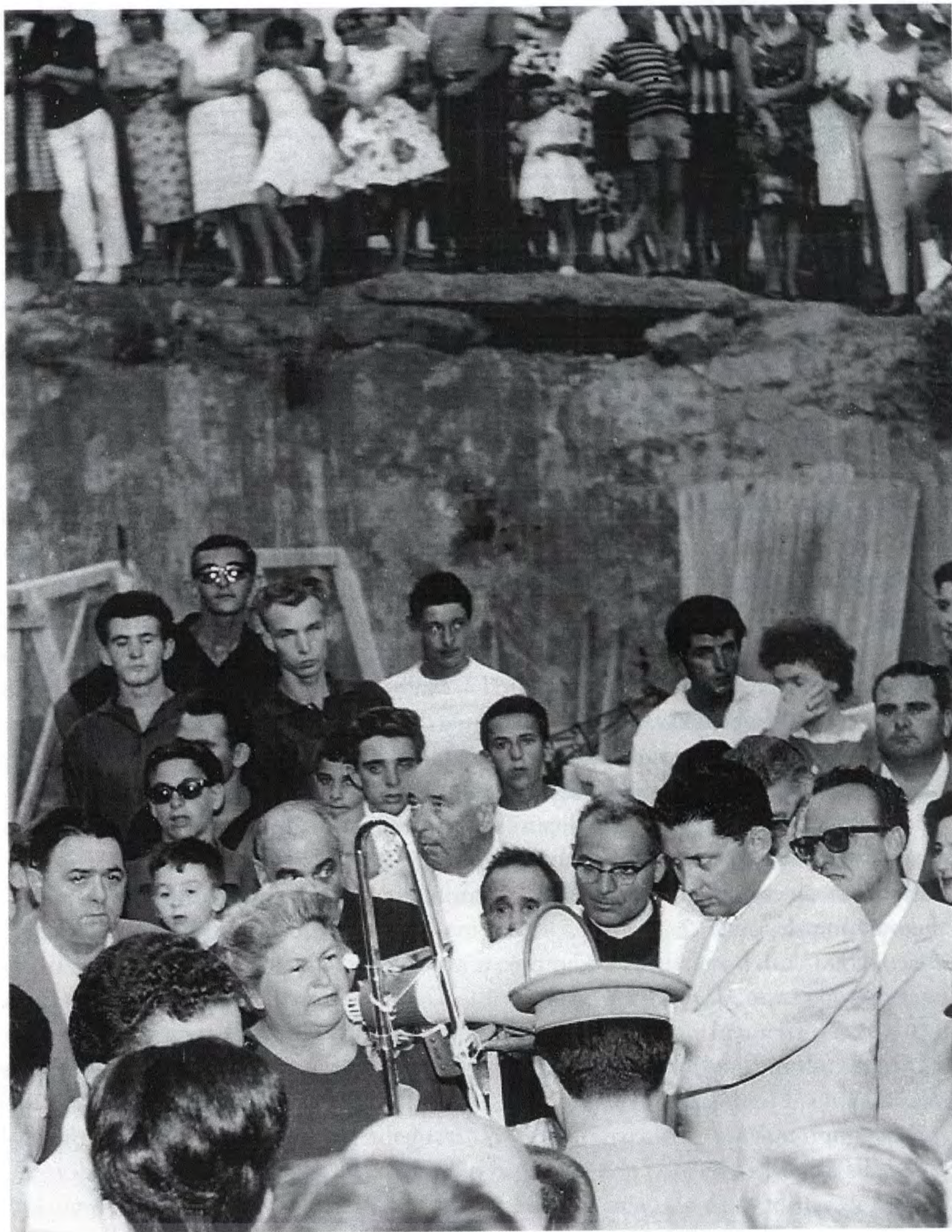
L'Onorevole Tonietti in mezzo ad una folla di riesi, in occasione della posa della prima pietra dell'attuale Municipio di Rio Marina. I lavori, iniziati alla fine del 1962, furono ultimati il 2 giugno 1964
