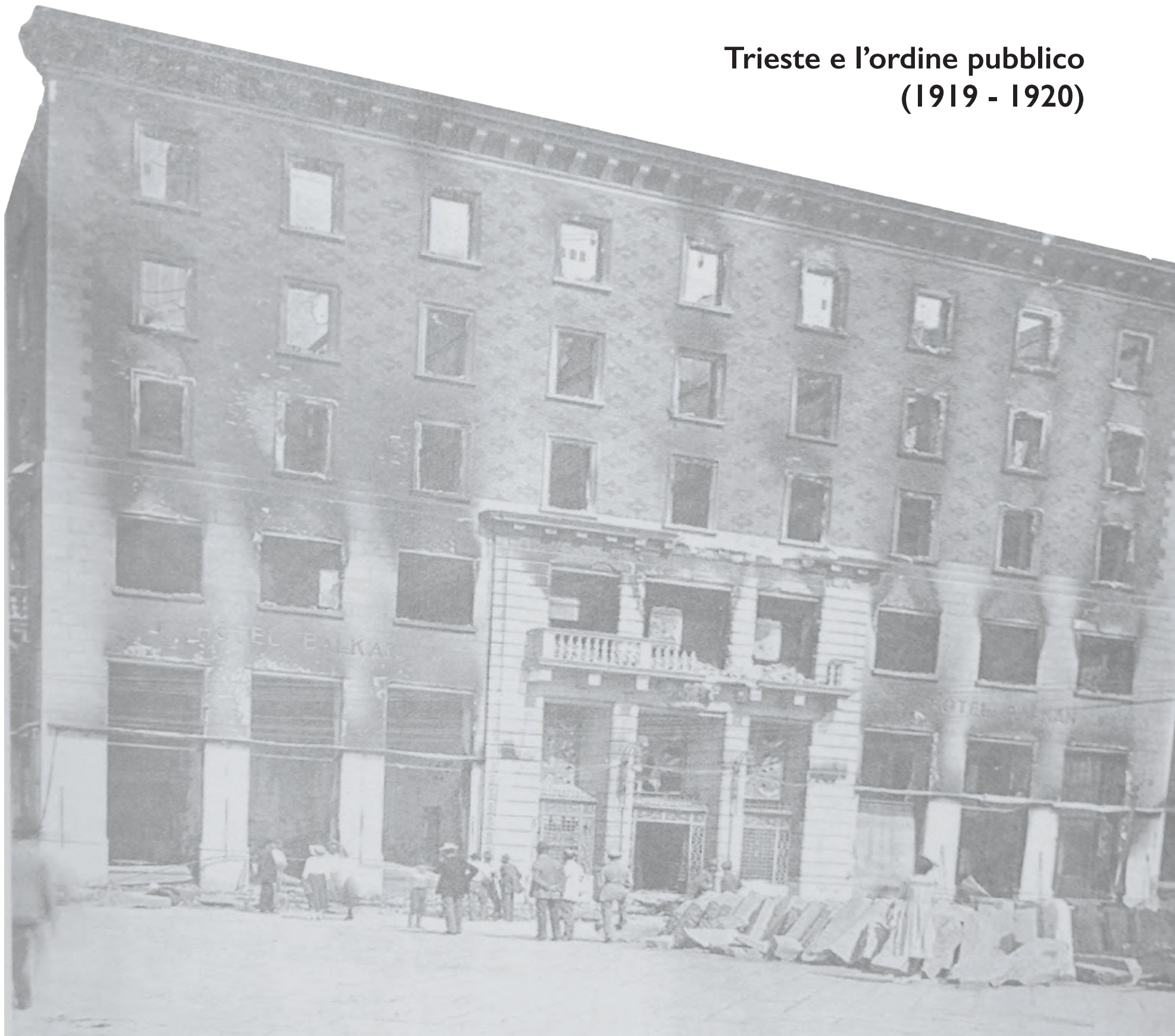
L'Hotel Balkan dopo l'incendio
