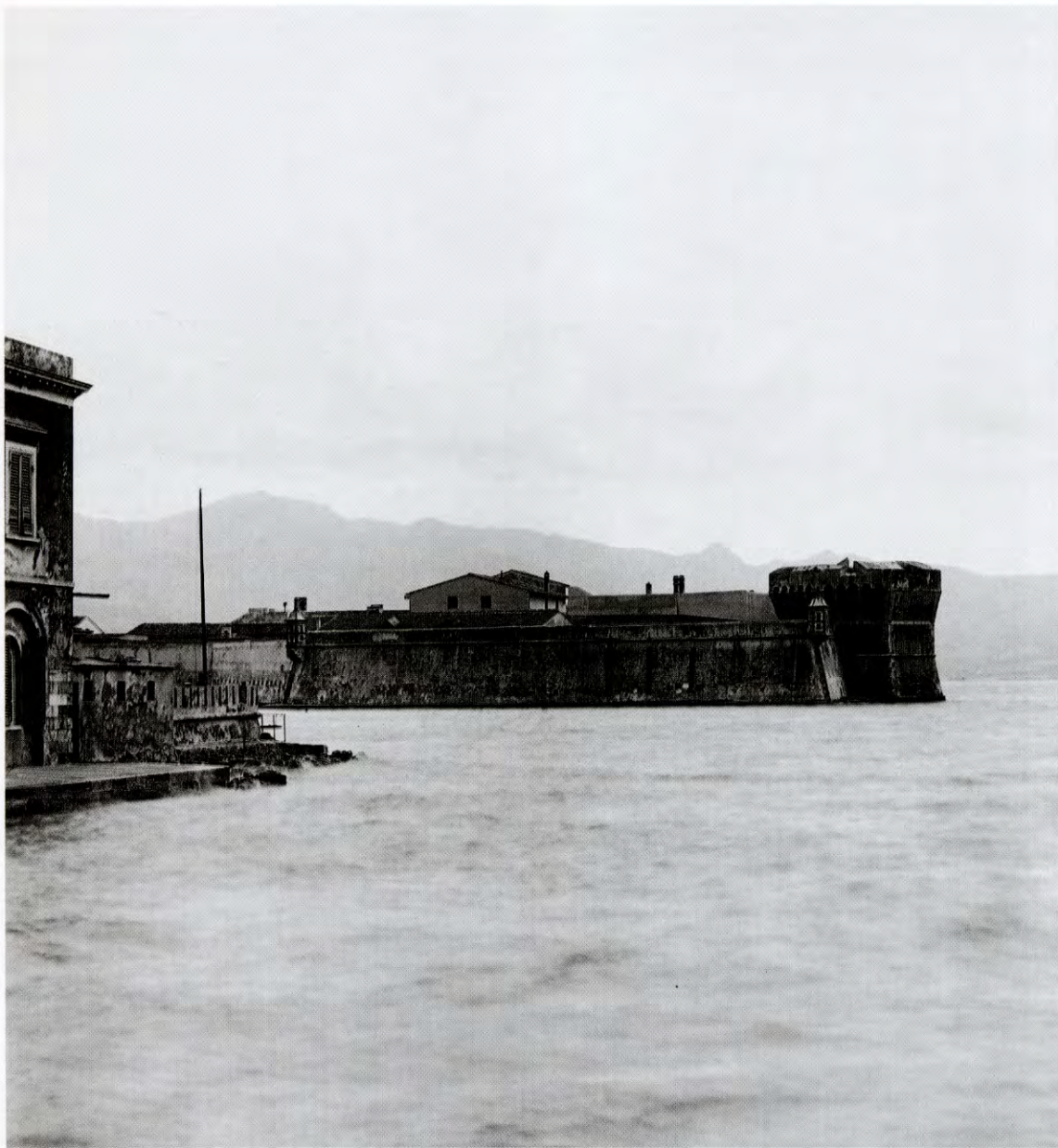
190. Torre della Linguella e opera di San Francesco: veduta intorno al 1925. Gabinetto fotografico della Soprintendenza per i Beni Artistici e Storici di Firenze, n. 17771.
