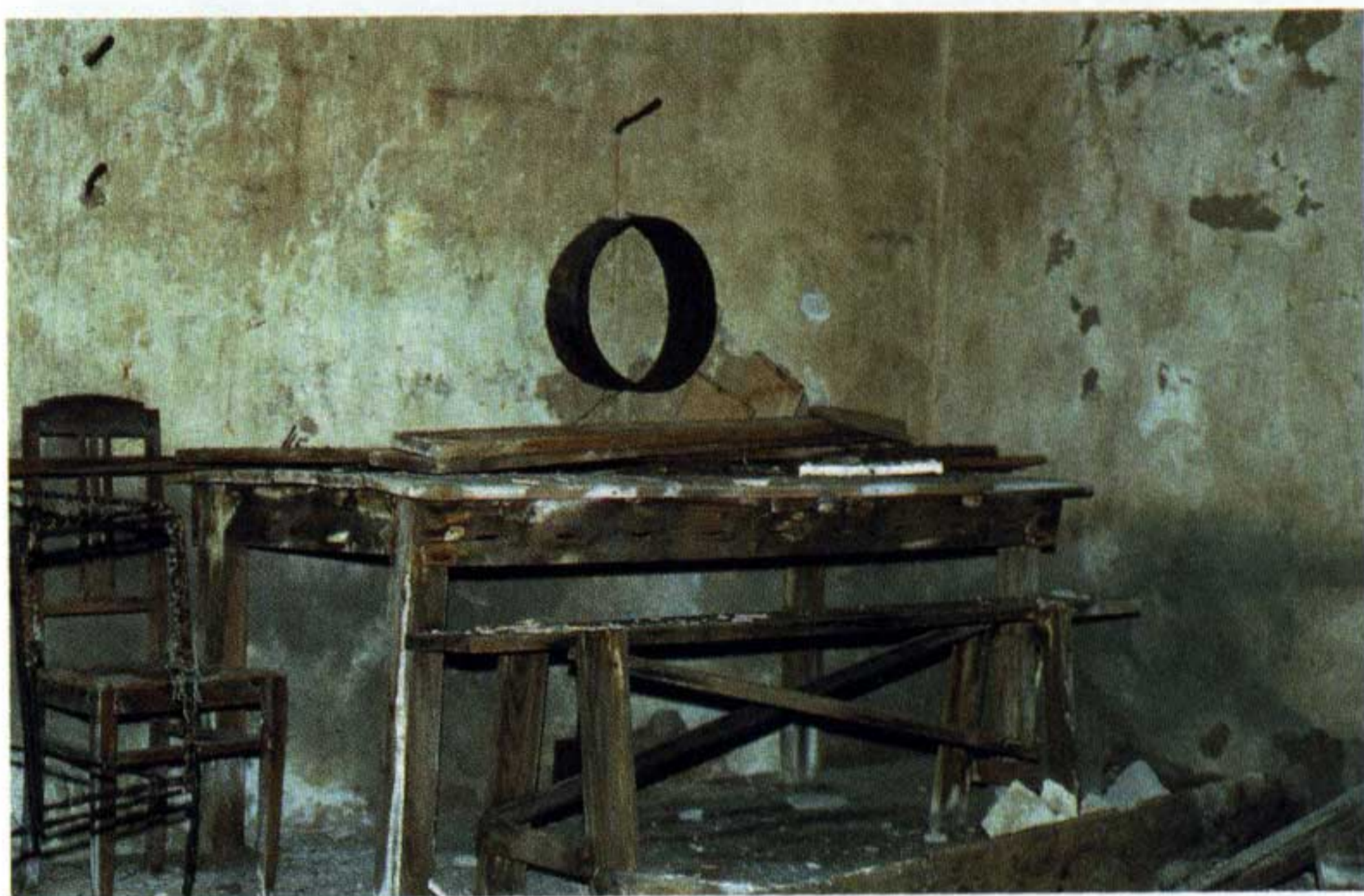
Un angolo del locale a piano terra denominato “baracca regia” prima dei restauri.
