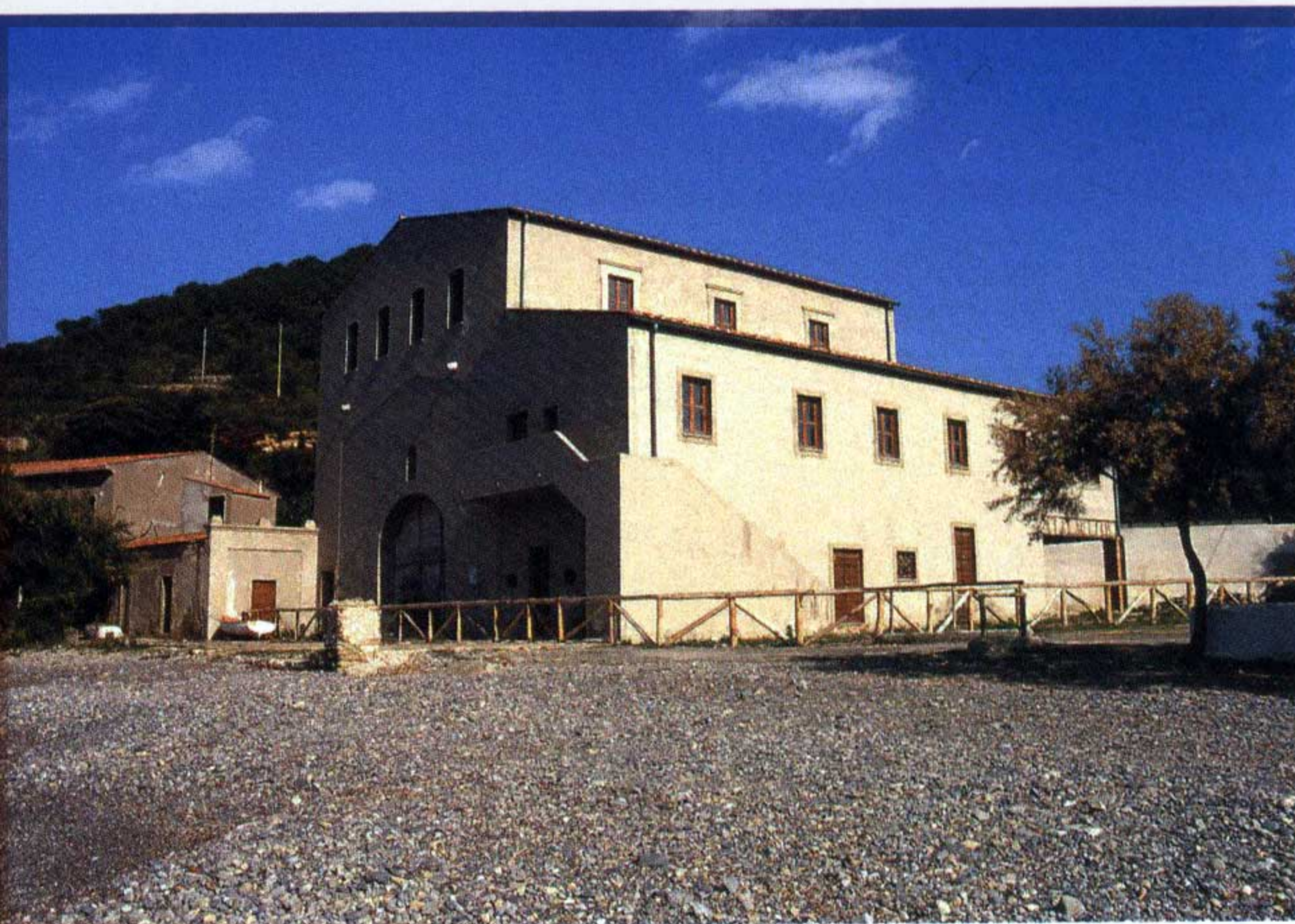
L'Arsenale come appare attualmente dopo i restauri della fine degli anni '90.
