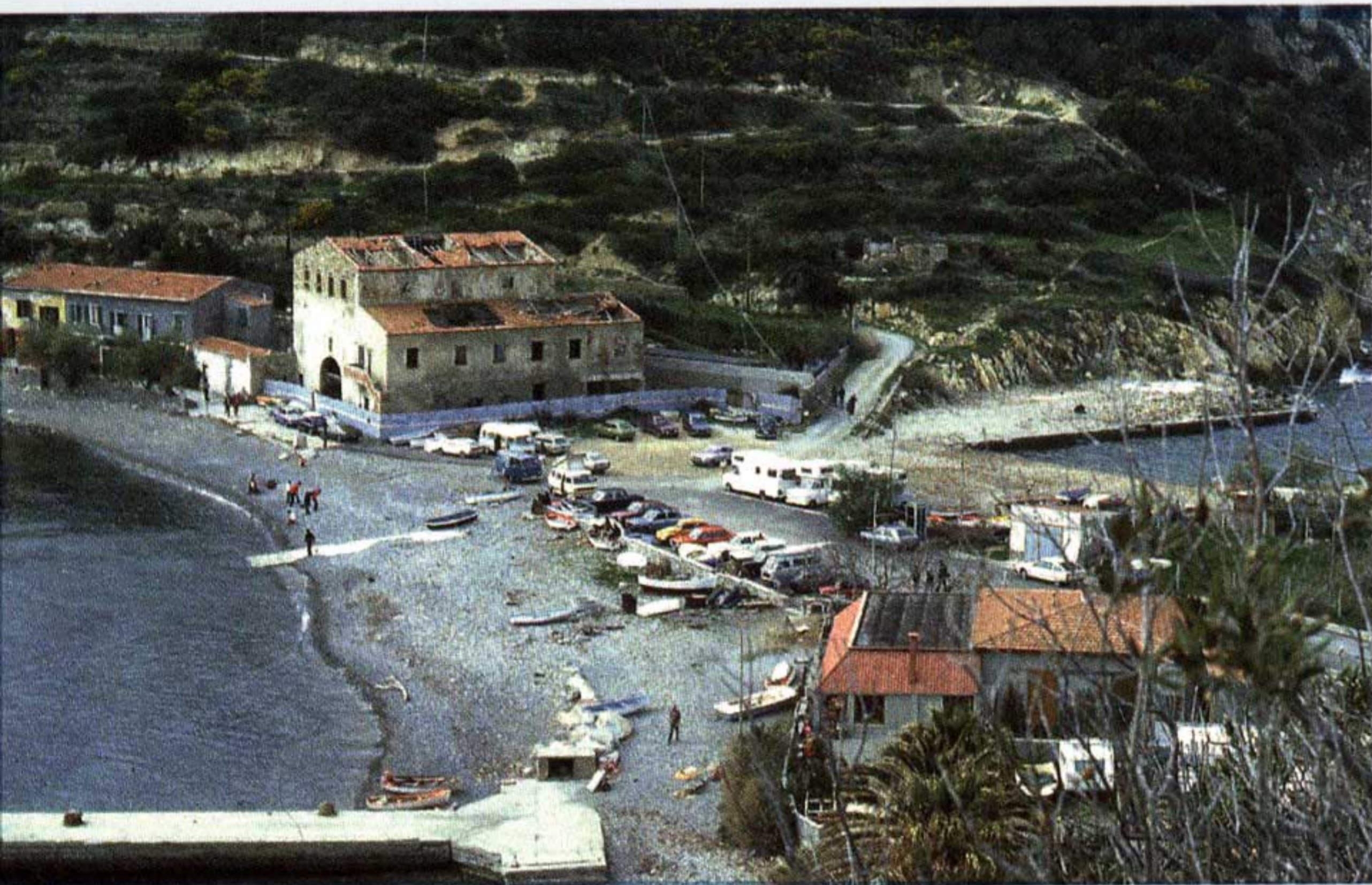
Lo stato di degrado a cui era giunta la struttura dopo trenta anni di incurie.
