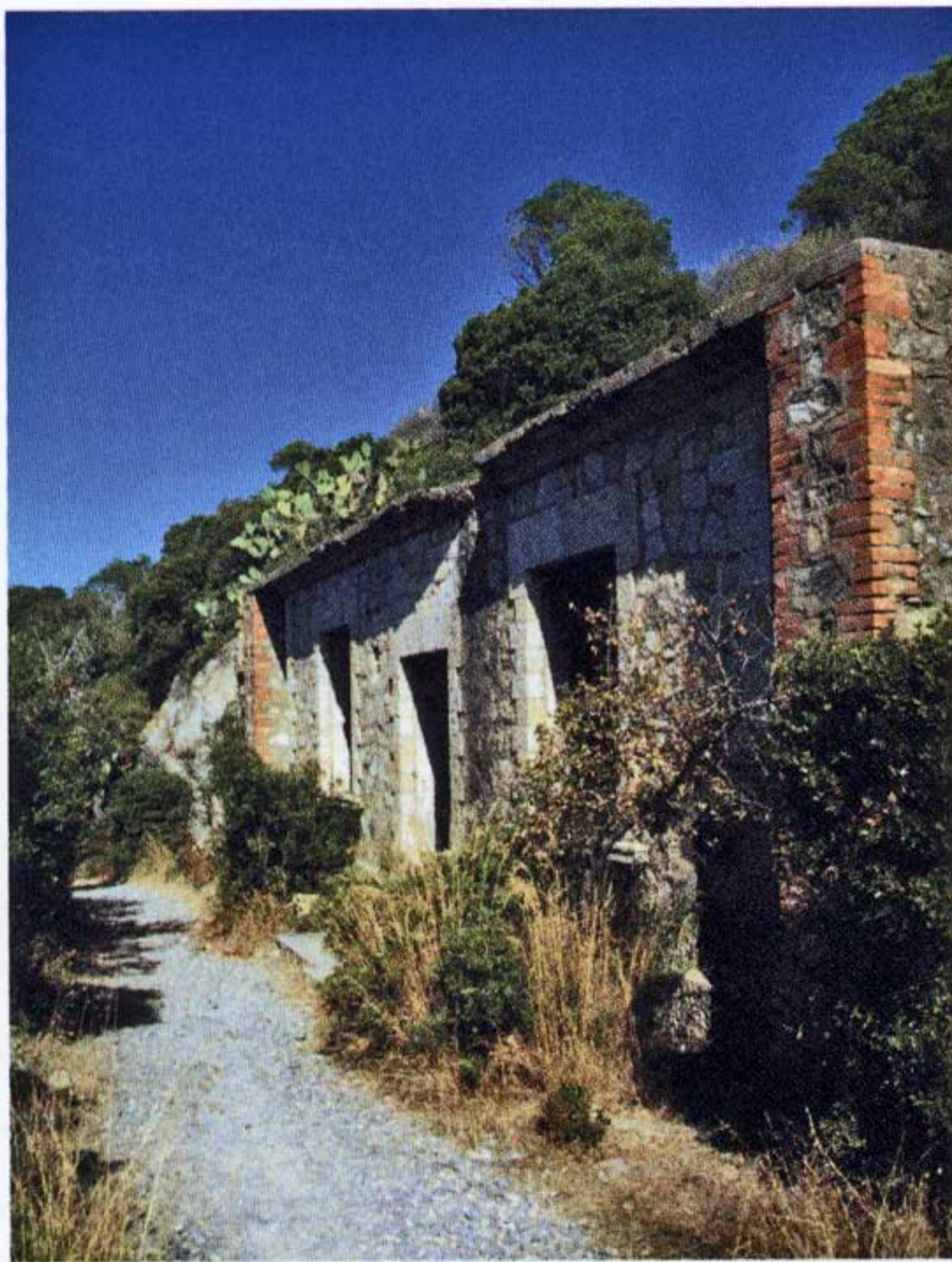
La centrale elettrica. Davanti, sul lato opposto della strada, si trova una cisterna. (vedi)
