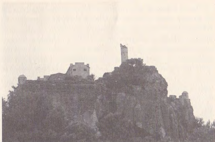
Isola di Capraia. Il castello San Giorgio. Veduta delle mura del lato meridionale. L'immagine mostra l'avanzato stato di degrado delle strutture interne ed esterne della pur sempre poderosa ed affascinante fortificazione, 1997.
