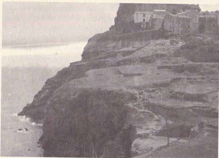
A.F.M.C.M.G. "E. A. D'Albertis", Capraia Isola, piazzale abbandonate presso la Cala di San Francesco, 1915 circa. Si notino il disfacimento dei muretti e il degrado in cui sembrano versare alcune case del paese.
