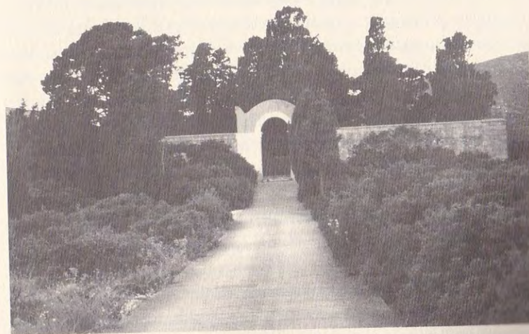
Capraia Isola, il cimitero comunale (secolo XIX) dalla strada di accesso, 2003.
