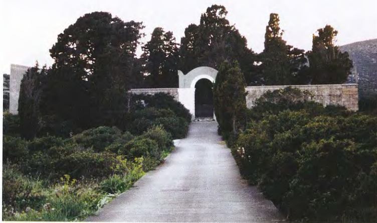
Capraia Isola, il cimitero comunale (secolo XIX) dalla strada di accesso, 2003.
