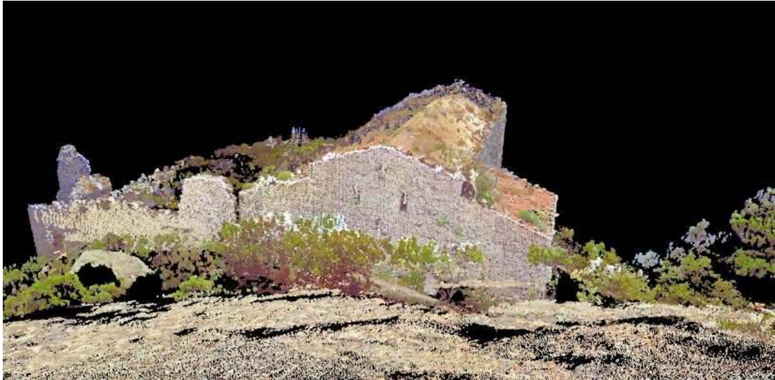
Fig.105 Vista ottenuta dalla nuvola di punti interna integrata con quella esterna
