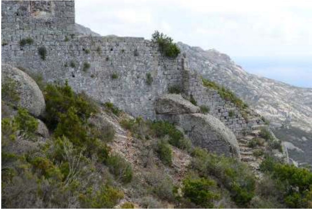
Fig.8 Particolare della scala esterna che portava all'ingresso della chiesa (foto 2013)
