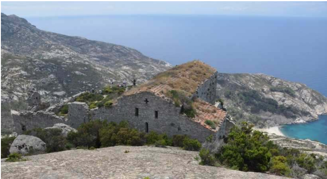
Fig.104 Foto presa durante il rilievo( foto 2013)
