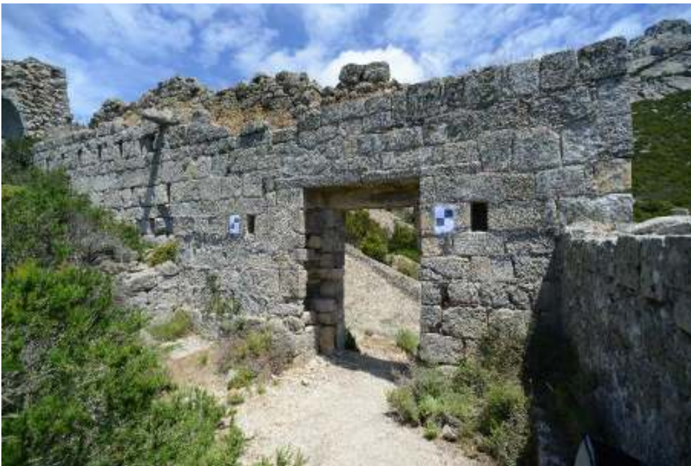
Fig.9 Particolare della porta di ingresso del monastero (foto 2013)
