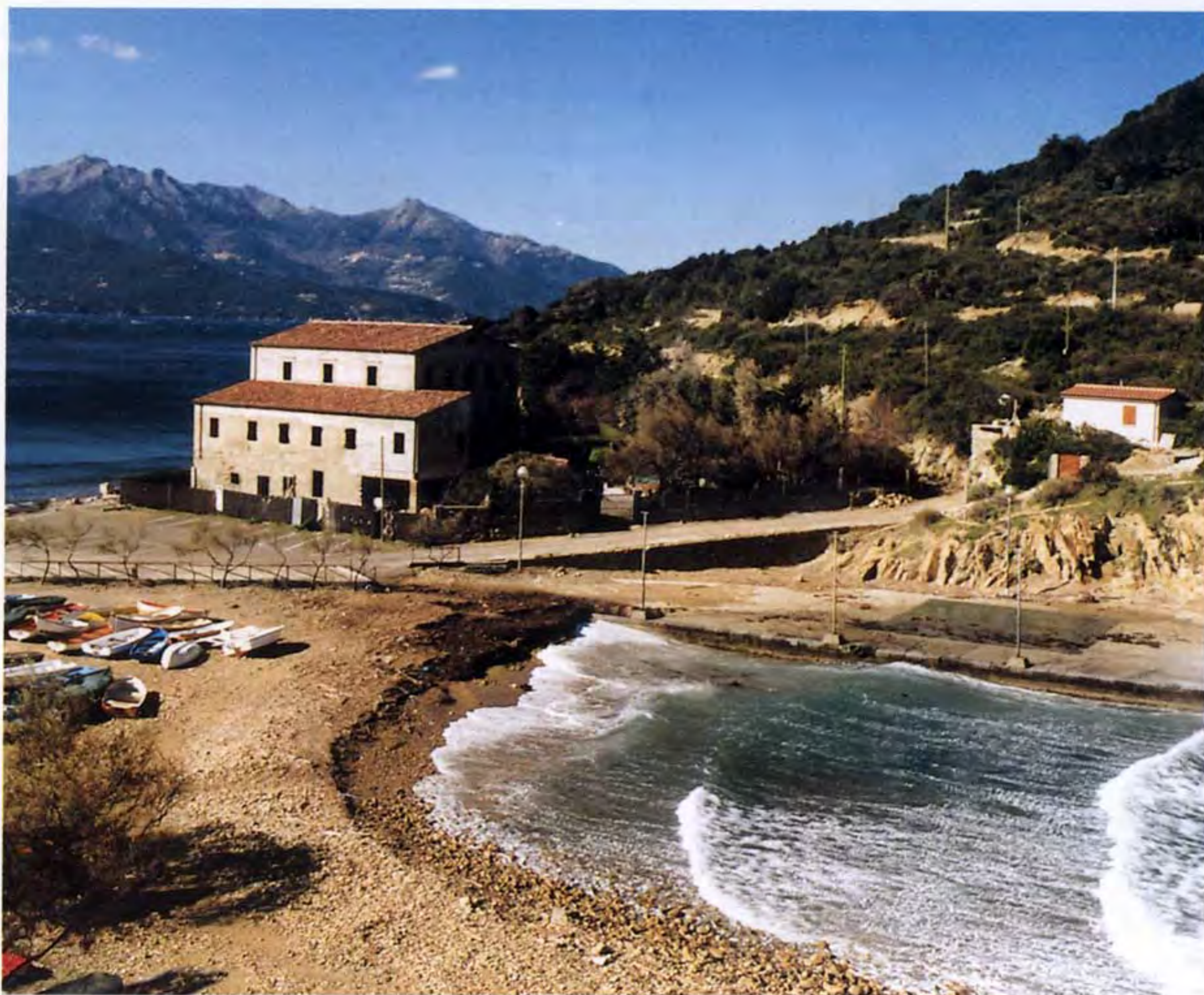
Foto recente dell'Arsenale dell'Enfole prima dei più recenti lavori di ristrutturazione.
