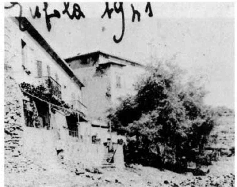
A lato: lo strano corridoio al piano primo dell'Arsenale dell'Enfola, rivolto verso il Viticcio. Nacque dal tamponamento finestrato del vecchio terrazzo.
