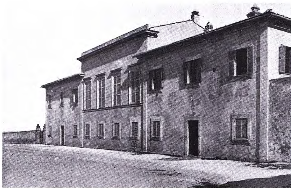
Fig. 66 - La villa dei Mulini al termine dei lavori
