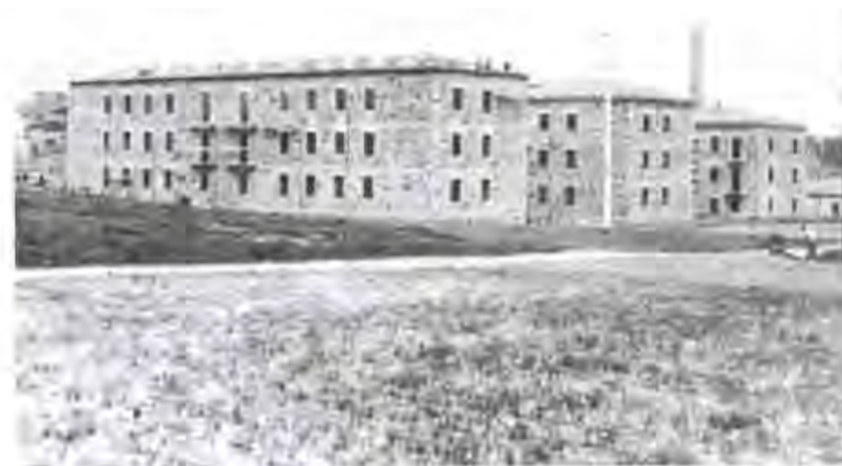
Le case popolari in costruzione
