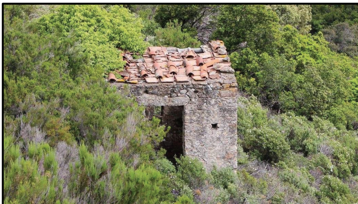
Il Magazzino Costa-Piacentini (42.766127, 10.130764)
