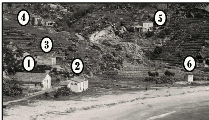
Cavoli nel 1908: l' Arsenale (1), la Casa Zimmer (2), il Magazzino Ricciotti (3), la Casa Lazzeri (4), la Casa Batignani (5) e il Casotto (6) da cui partiva il cavo telegrafico sottomarino tra l'Elba e Pianosa
