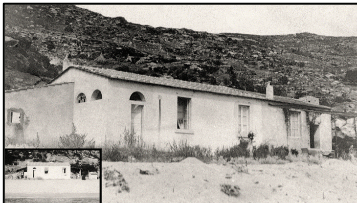
La Casa Zimmer prima (nel riquadro) e dopo i due ampliamenti laterali
